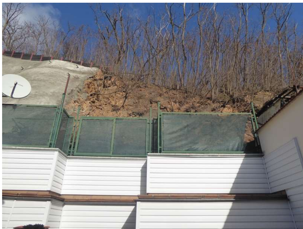
Skalní svah nad opěrnou zdí za domem č. 58. Na skále přítomny náletové dřeviny. Nad horní hranou skály bude umístěn ochranný plot, podobně jako nad již sanovanou skálou vlevo.
