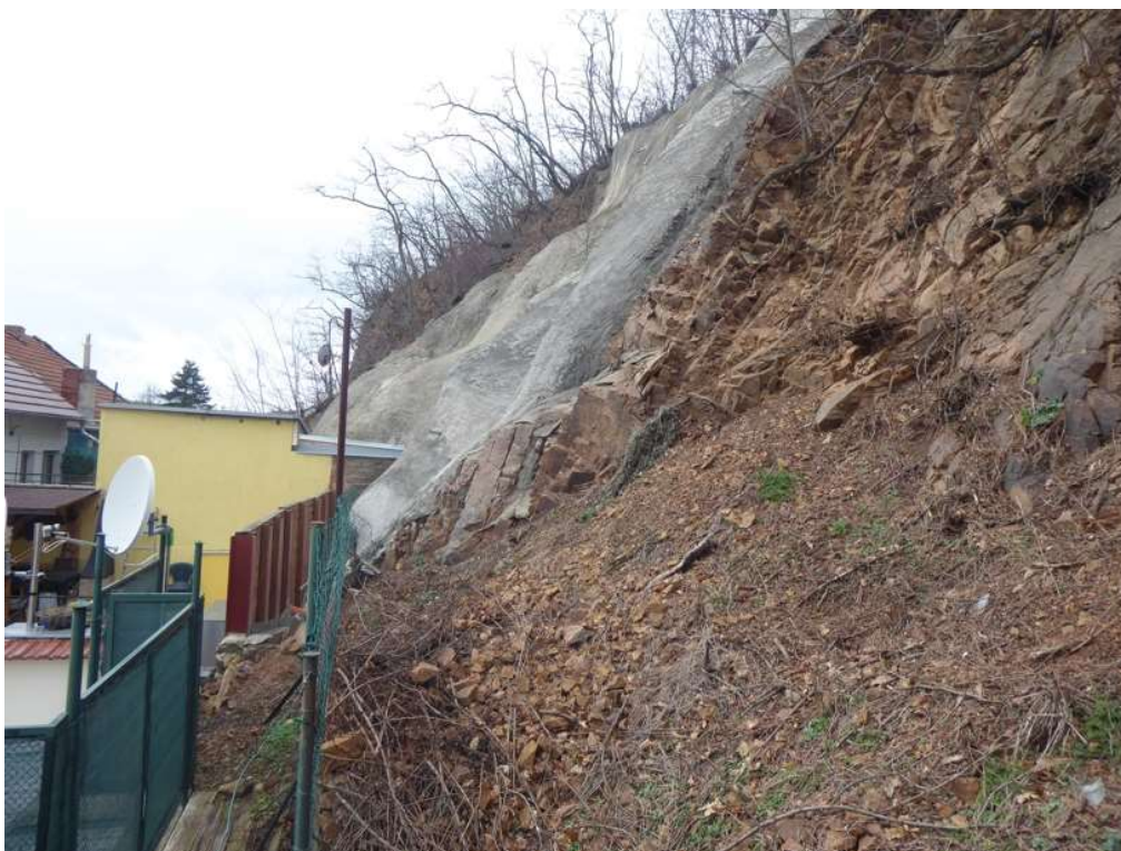
Skalní stěna za domem č. 58 s velkým množstvím opadáných kamenů v akumulční oblasti. Svah za sousedním domem č. 60 již byl sanován stříkaným betonem.
